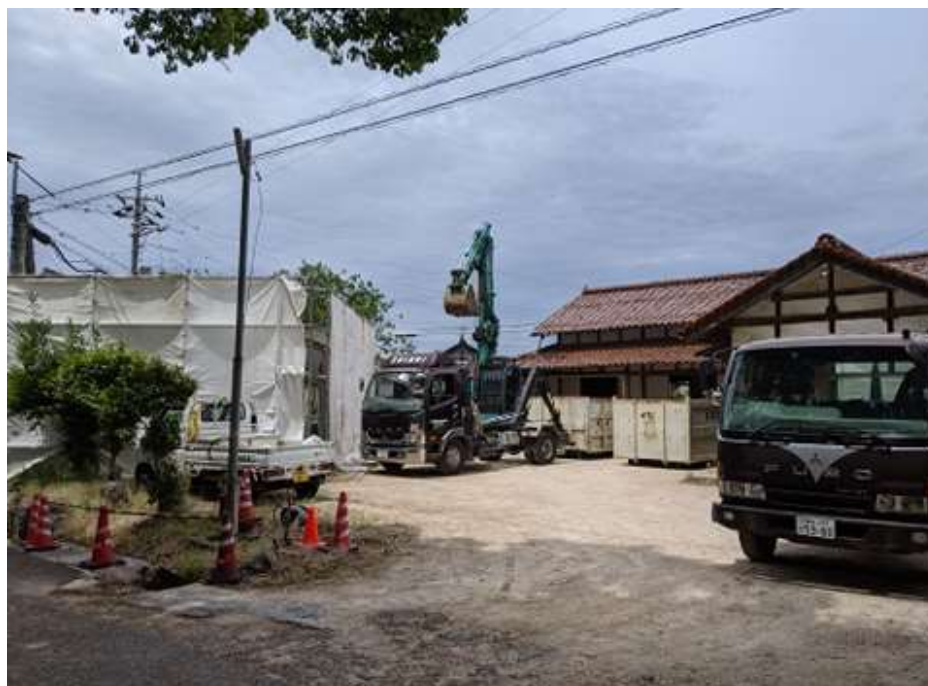
<福庭自治公民館解体工事開始（2021年6月3日撮影）>
